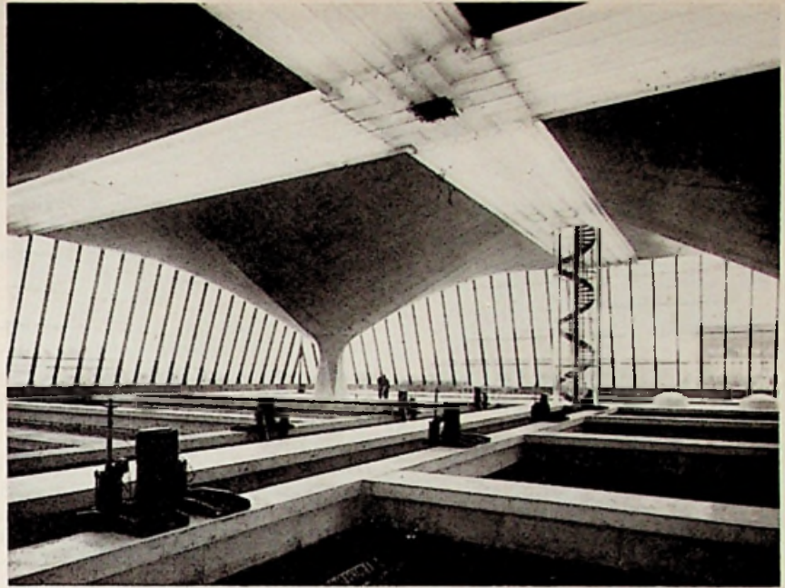
Afb. 4. Detailopname van het filtergebouw met snel- en vlokkenfilters. Op de achtergrond een deel van het machinegebouw.
